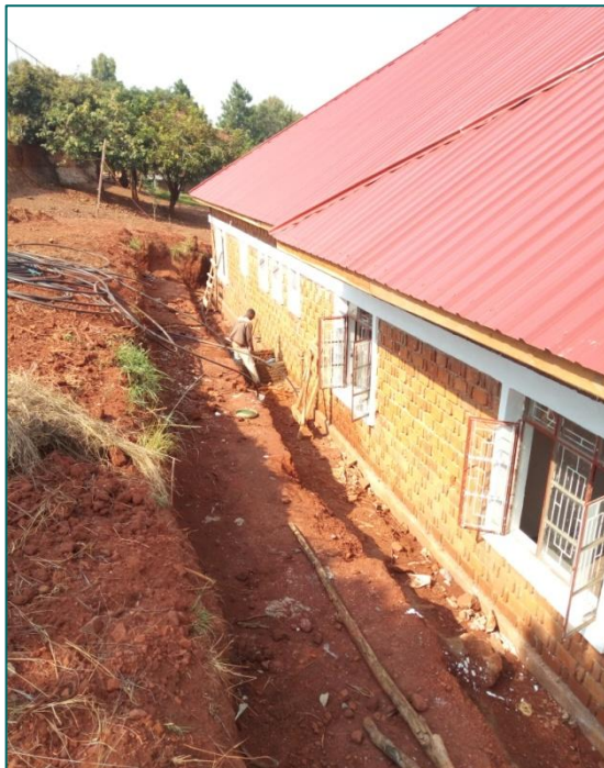
Planeringen på bjergsiden samt en del af den sorte slange til det varme vand.
