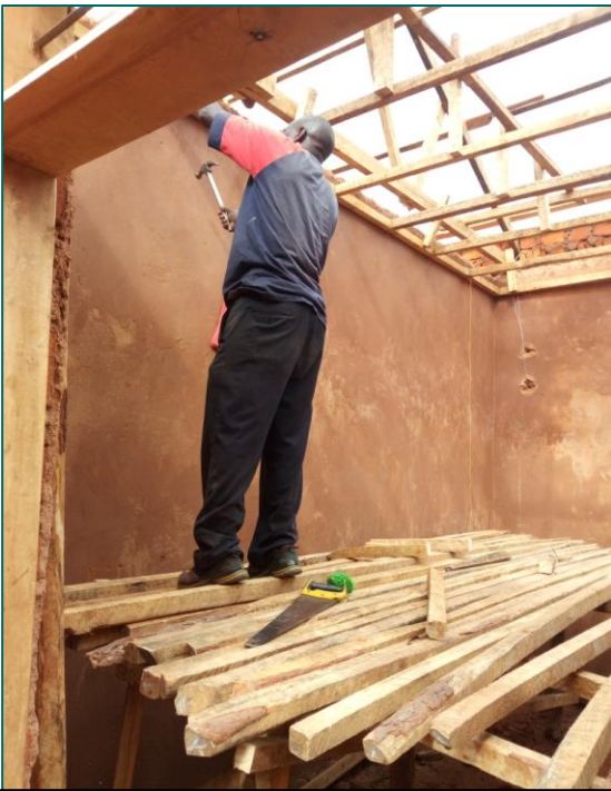
20.12.2019: Skellettet til loftsplader opsættes.
