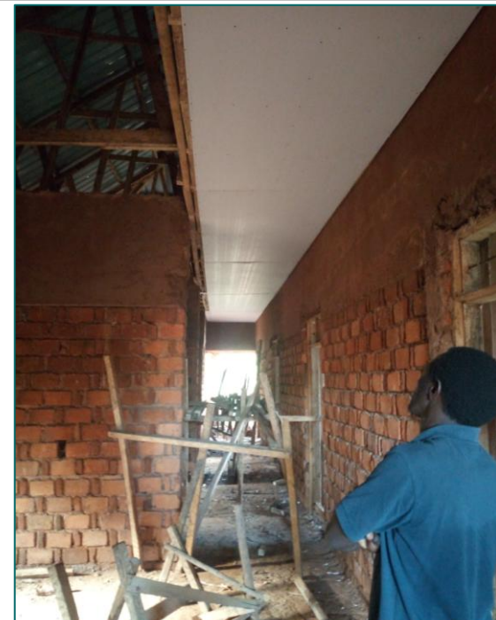
20.12.2019: Loftspladerne i gangen er monteret.
