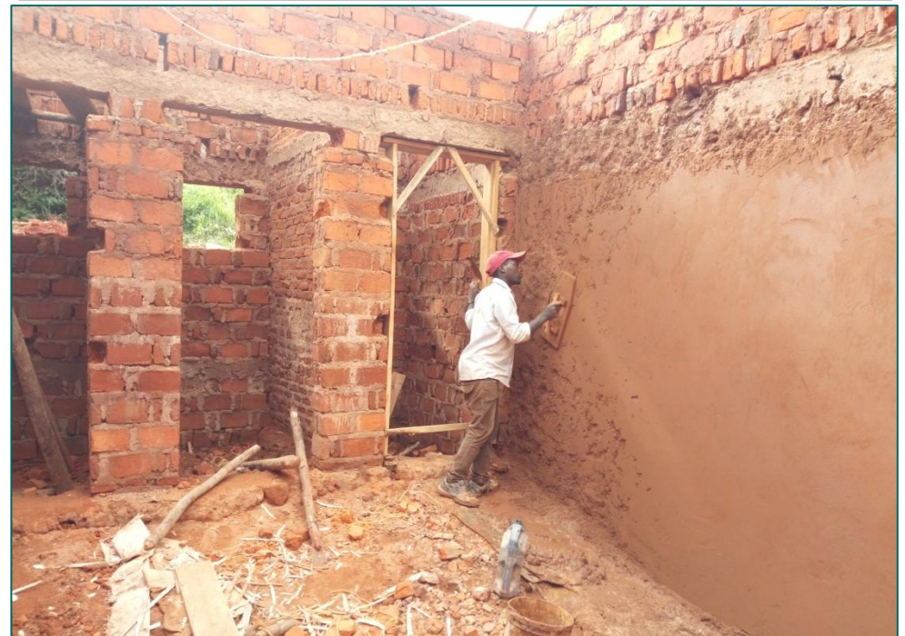
20.12.2019: De indvendige mure pudses og dør-rammerne indsættes.
