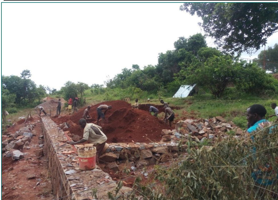
15.11.2019: Byggeriet set fra den modsatte side.
