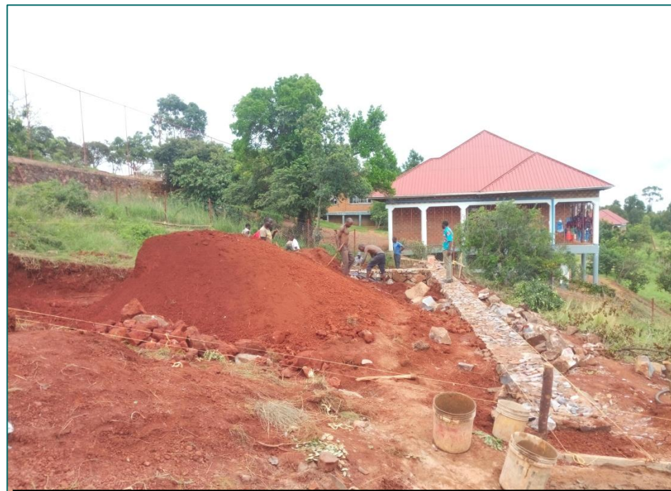
15.11.2019: Der graves ud og planeres samtidig med at fundamentet bygges.
